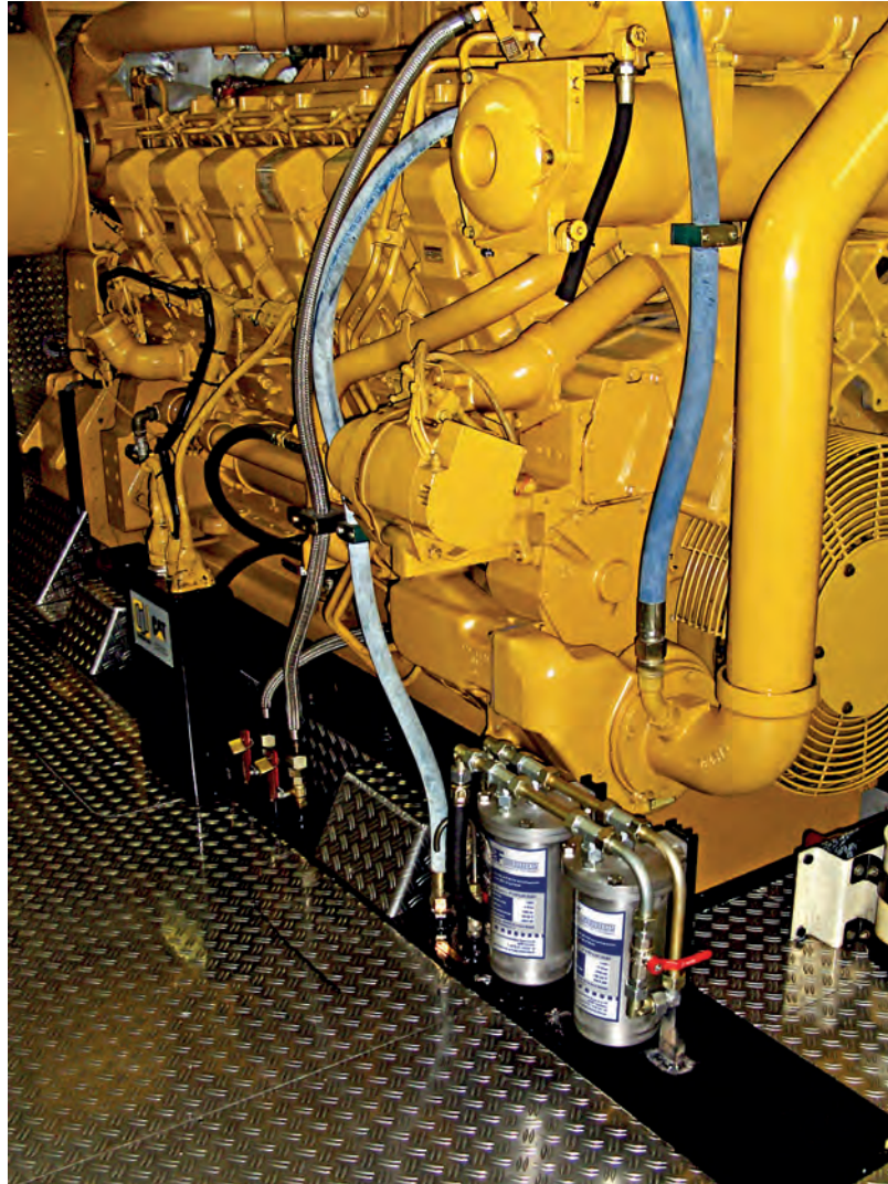
Ultrafein-Filterung von Schmieröl ■ © Horst Weiland
